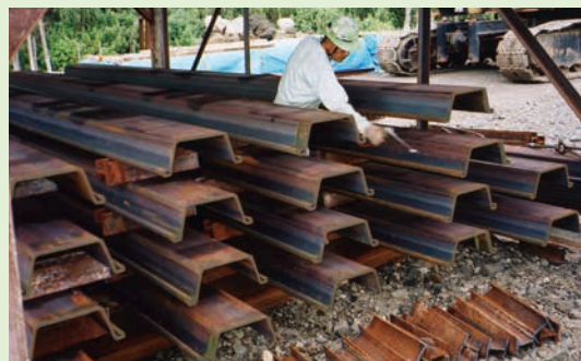
写真-4 鋼矢板の重ね置きとエアブロー作業
