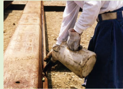
写真-9 流し込み
