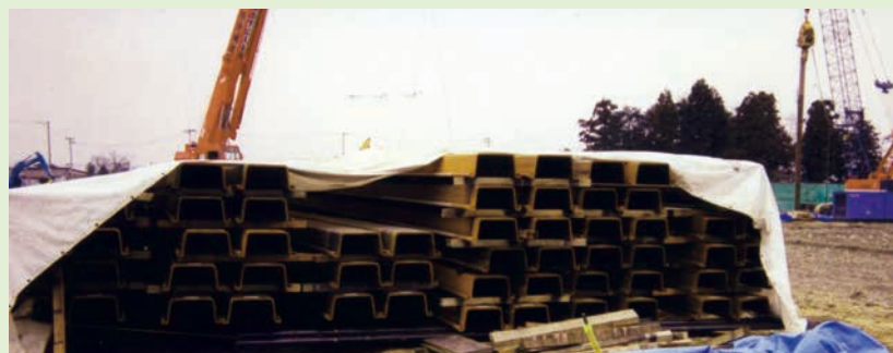
写真-10 養生(硬化)の例
