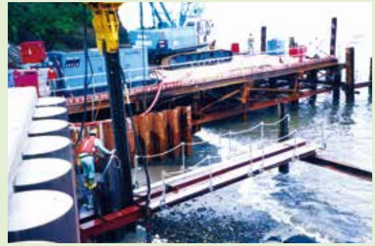
写真-11 打込みの例
