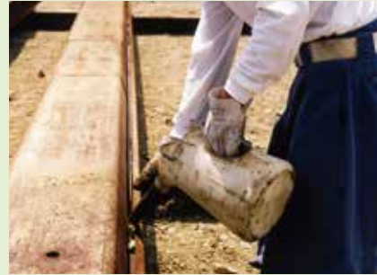
写真-9 流し込み
