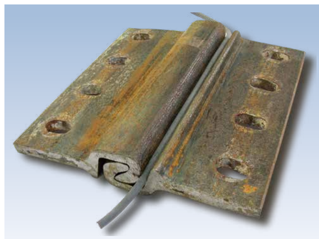
写真2 止水コードの施工状況
