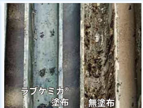
引抜き後の鋼材表面
