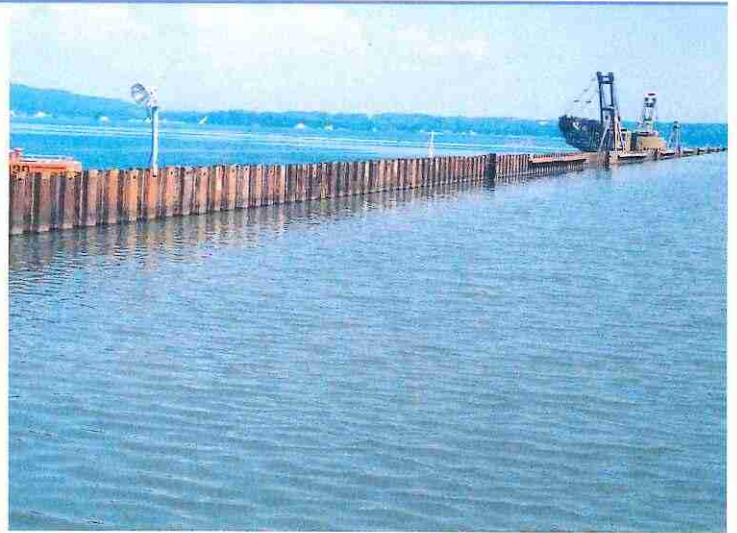
写真—13 締切工法
