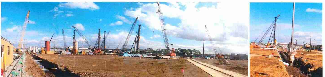
写真—18 遮水壁工法
