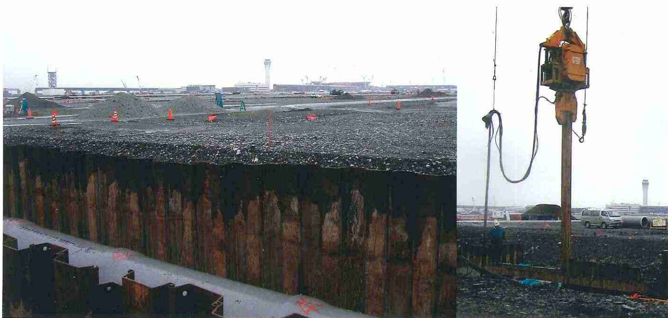
セントレア空港雨水排水管施設工事 施主: 中部国際空港(株) 建設会社: 熊谷・西松・徳倉 J V
