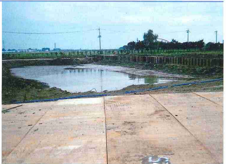
写真—16 土留工法
