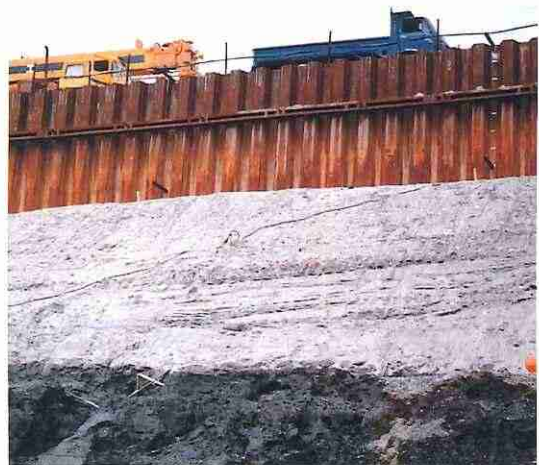
写真—15 土留工法
