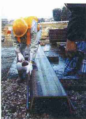
写真—6 流し込み
