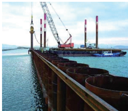
写真2 鋼管矢板遮水壁
