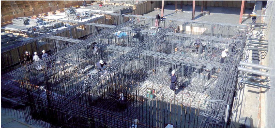
写真-1 鉄筋施工例
