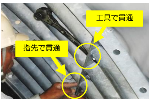
図3 ボルト穴の処理
