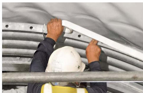
図2 貼付け施工状況
