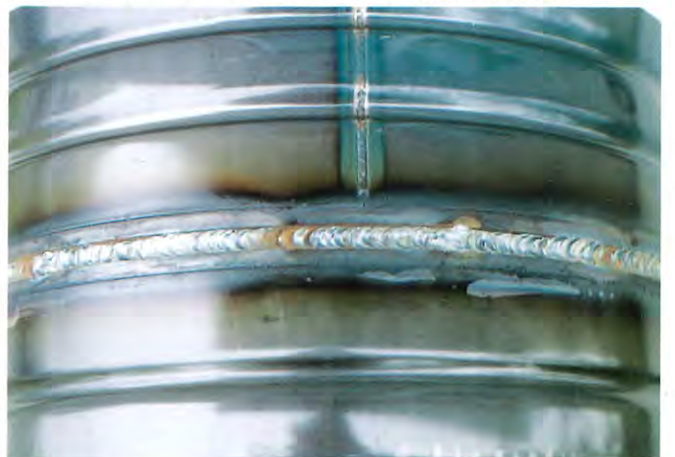
写真-3 ◆ サルフィックスWを塗布後の溶接部
