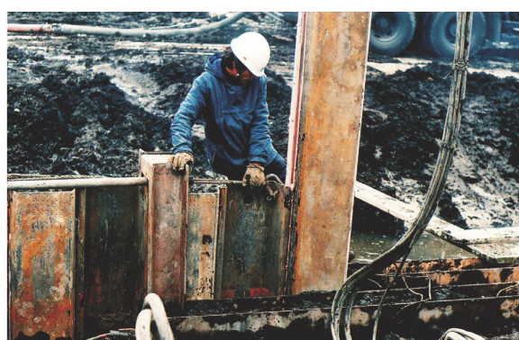
写真2 鋼矢板の打設状況
