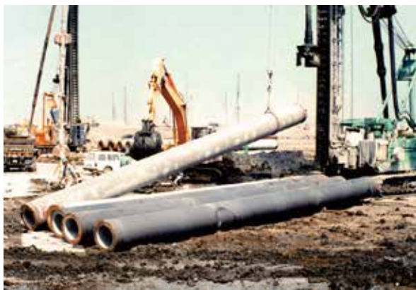
負の摩擦力対策杭施工状況
