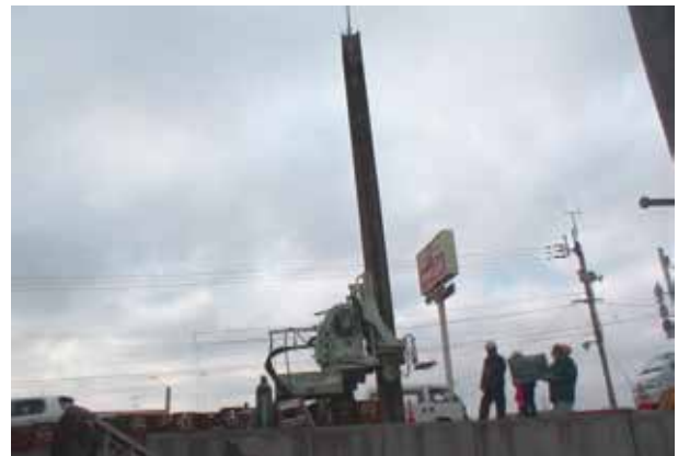
鋼矢板引抜き状況
