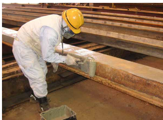
塗装作業(ローラー)
