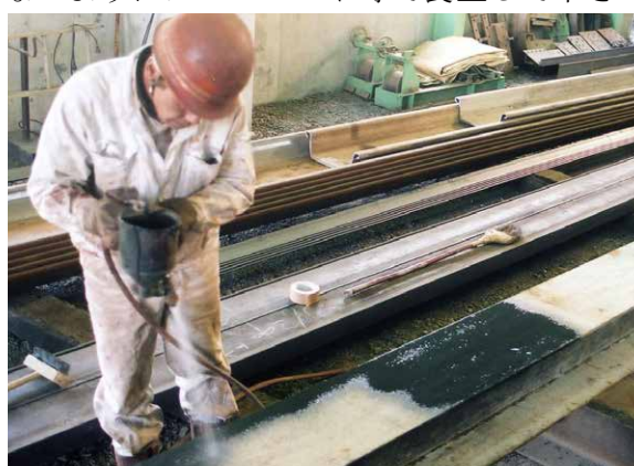
塗装作業(リシガン)
